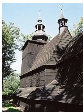
教会の塔に設置さ れた避雷針
